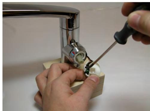
**4. Entfernen Sie den Schalter aus dem Griffadapter**
